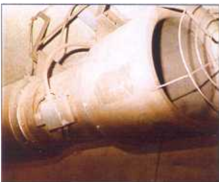
Beispiel eines nachträglich zum «Banana-Jet» umgerüsteten Strahllüfters.
